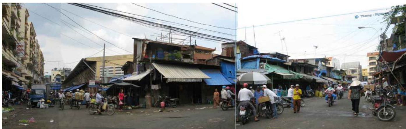
Ảnh C.5. Mặt phía nam chợ Bình Tây Nguồn: DCU
